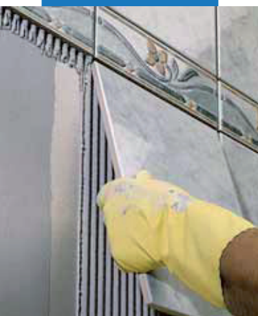
Lepenie jedenkrát pálených obkladov na stenu kúpeľne s omietkou
