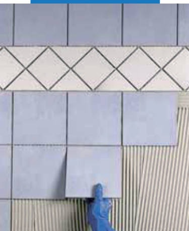
Lepenie jedenkrát pálených obkladov na stenu zo sadrokartónu
